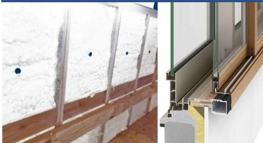
外皮断熱（発砲ウレタン吹付）/開口部（内窓設置）
