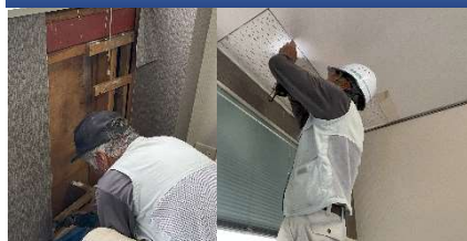
既存建物状況調査
