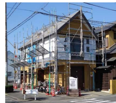
施工中 木製の外壁をはがし、防水シート・ガルバリウム鋼板を張り替えました。
