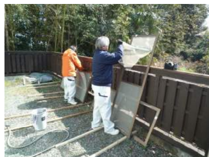
持ってきていただいた網戸は、古い網を取り外して枠を水洗いするところからお手伝いしています。
