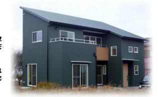
外観は、屋根と外壁を統一したモスグリーンのガルバリ ウム鋼板を使用しました。正面には玄関ドアと同色のサ イディングを一部張リアクセントを付け、シンプルモダン
