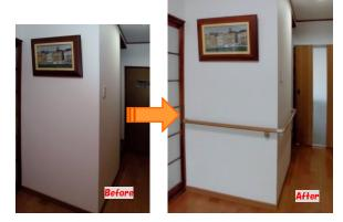
玄関の段差を上がる、トイレ から立ち上がるなど、必要な 箇所に手すりを設置しまし た。ただ空いている壁に取り 付けるのではなく利用される 方の自発的な運動を促すよう に、取り付け箇所や位置を考 慮して設置をします。
