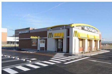
マクドナルド 1 号線小坂井店新築工事
