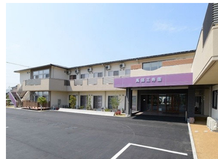
老人ホーム新築工事
