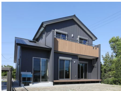
戸建て住宅新築工事
